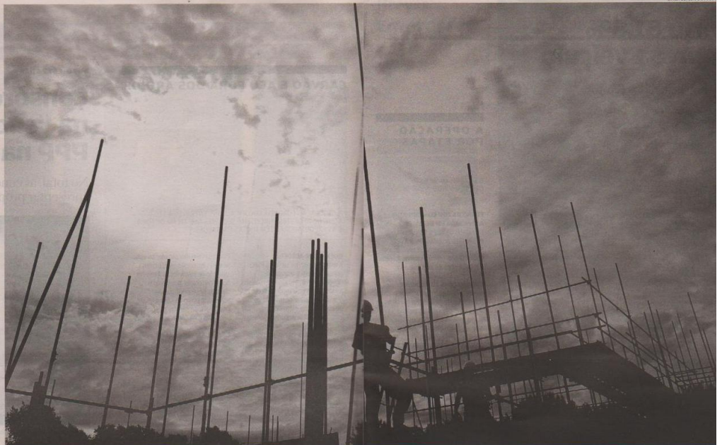
"Obras" em atraso no Governo | O Regulamento dos Produtos da Construção, que revogou a Directiva comunitária, foi publicado em Março de 2011 e só entrou em plena aplicação a 1 de Julho deste ano.
